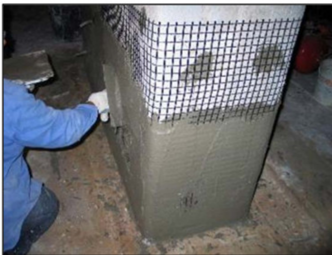
Figura 2.9 – Confinamento di pilastro di muratura con rete di vetro AR.
