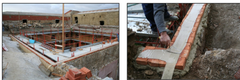
Figura 2.7 – Cordolo sommitale realizzato con tessuti a base di reti di acciaio.
