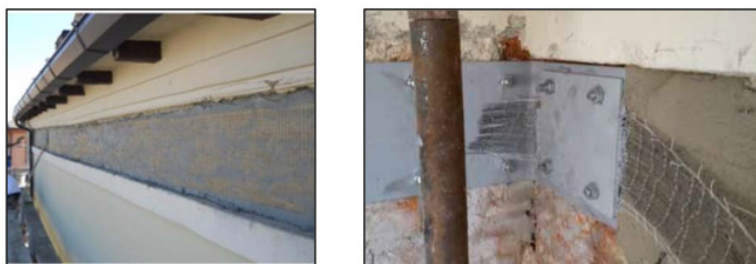
Figura 2.6 – Cordolature di piano realizzate con tessuti di PBO e acciaio.
