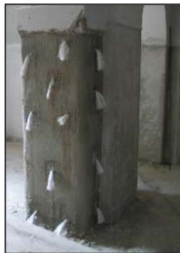
Figura 2.9 – Confinamento di pilastro di muratura con rete di vetro AR.
