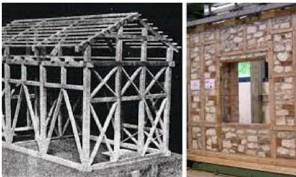
Sistema costruttivo antisismico Borbonico : La casa Baraccata
