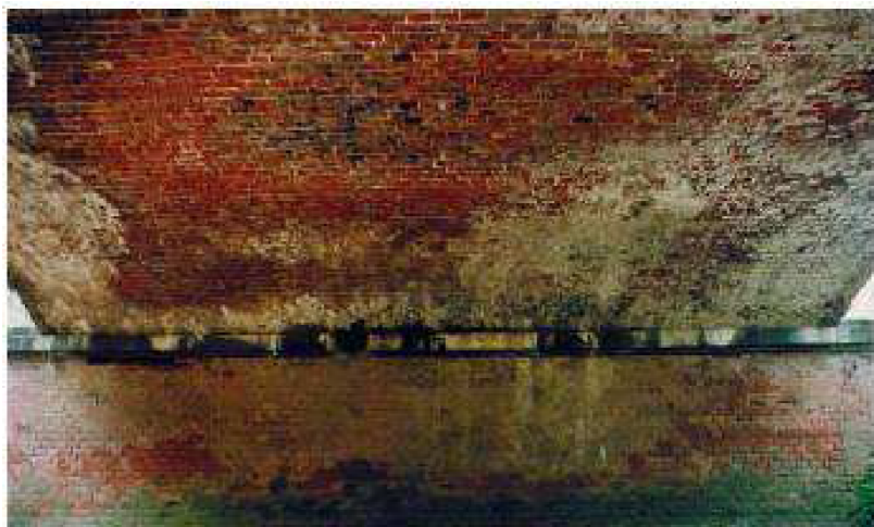
Figura 30. Arco realizzato secondo tessitura retta – (Archivio FS – TO)
