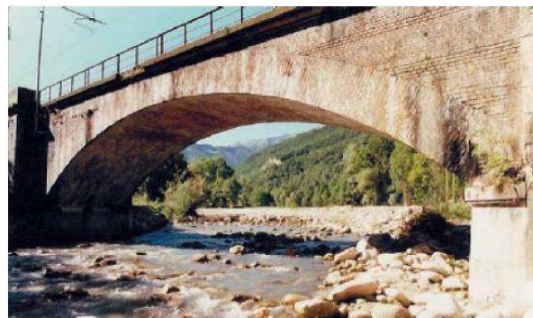
Figura 4 Arco a sesto ribassato - linea Cuneo-Limone, ponte Vermentagna, progr. 19+403
