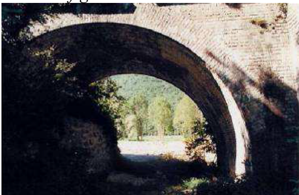
Figura 4 Arco a sesto ribassato - linea Cuneo-Limone, ponte Vermentagna, progr. 19+403
