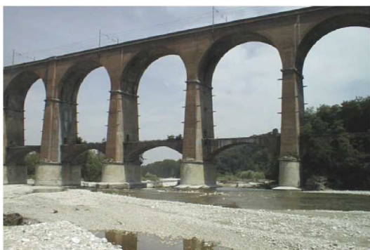
Figura 7 Viadotto Stura - linea Fossano-Ceva, progr. 2+606 (Archivio FS-TO).
