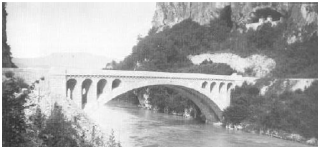
Figura 48. Rinfianchi alleggeriti da archi secondari, ponte sul Rodano a La Balme (Grattasat ed., 19
