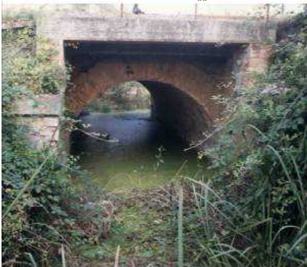
Foto di un ponticello da 3 metri di luce (chilometrica 111+714)
