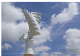
Turbina eolica ad asse verticale con elementi di presa sul vento AUTO-ORIENTABILI
