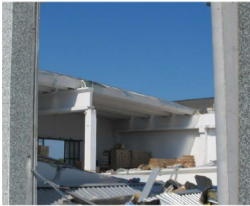
Figura 11 - Perdita di appoggio della trave per rottura connessione in un edificio con trave principale trasversale
