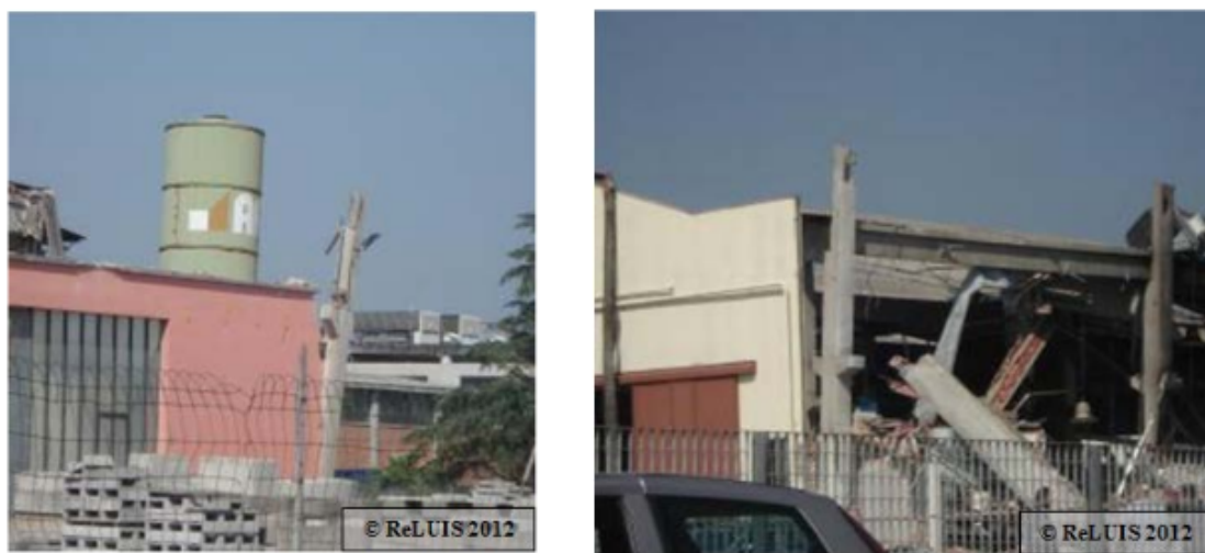
Figura 47 – Perdita di verticalità dei pilastri per probabile problema in fondazione
