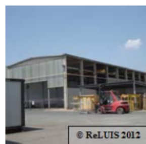
Figura 26 – Collasso pannelli orizzontali di tamponamento in strutture monopiano prefabbricate
