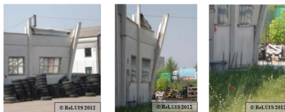
Figura 49 – Perdita di verticalità del pilastro per rottura alla base per cause non accertabili
