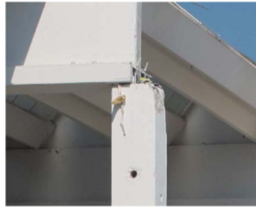
Figura 11 - Perdita di appoggio della trave per rottura connessione in un edificio con trave principale trasversale
