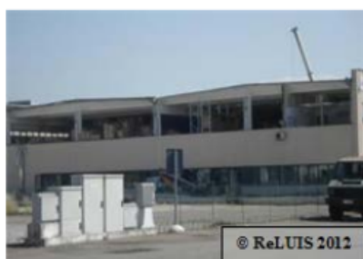
Figura 26 – Collasso pannelli orizzontali di tamponamento in strutture monopiano prefabbricate
