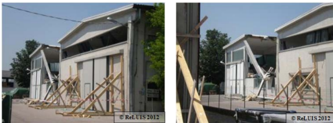
Figura 3 – Perdita di appoggio della trave principale in un edificio monopiano prefabbricato con travi principali trasversali costruito recentemente in ampliamento di un edificio esistente con connessione trave-pilastro attrittiva
